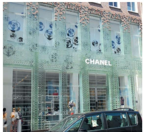
Für die Fassade des Chanel-Geschäfts in der P.C. Hoofstraat, Amsterdam, wurde ein massiver Glasbaustein gewählt. Die Glasfassade geht nach oben hin allmählich in eine Ziegelfassade über. Das stellte eine neue Herausforderung für die Statiker dar. Die Lösung wurde in Ziegeln gefunden, die um einen Kern aus Glas geformt wurden. (Foto: de Kluijver, 8.5.2013)
